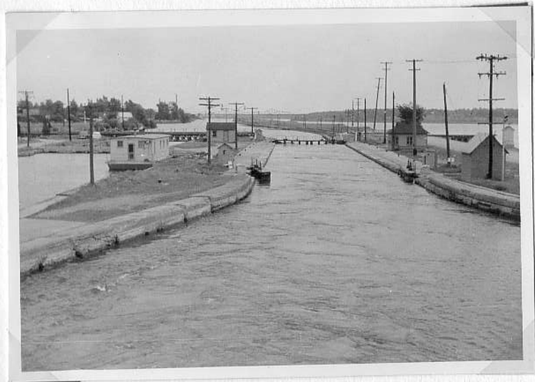
der Cornwall-Kanal; nebenan River St. Lorenz
