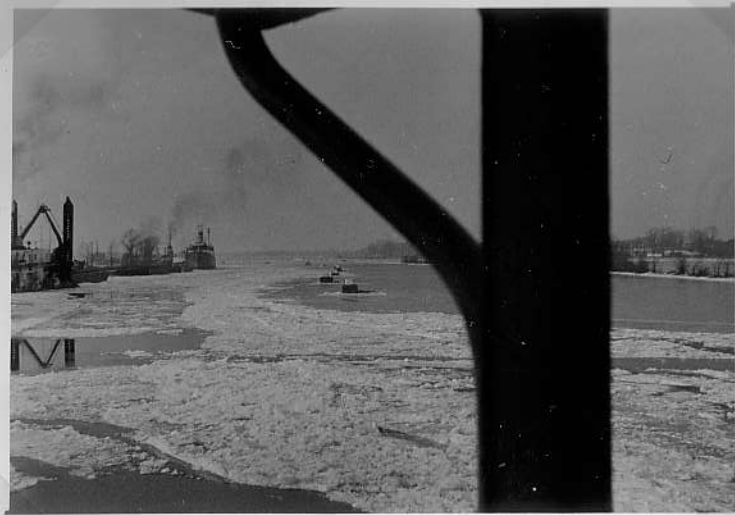
die letzte Schleuse des La-Chine-Channel
