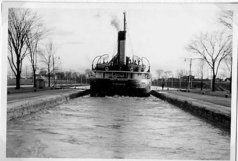
dieselbe Schleuse geflutet
