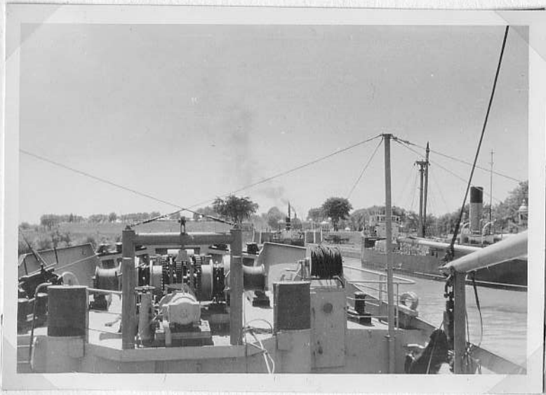
die ersten Schleusen, der ins: gesamt 28, des Soulangen-Kanals
