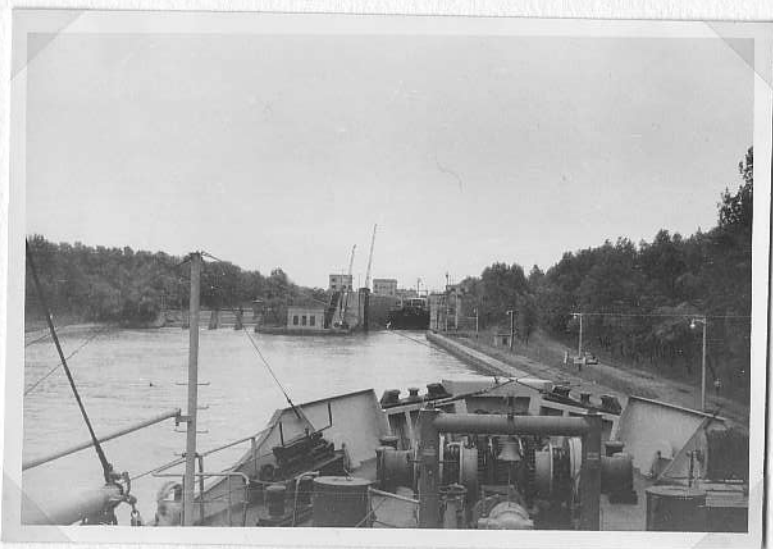
die erste Schleuse des Welland- Kanals bei Port Weller
